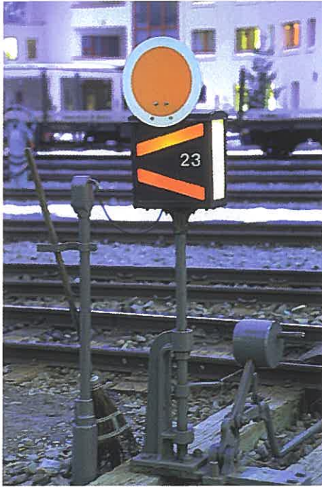
Weichenlaterne, Abzweig Stumpengleis.
