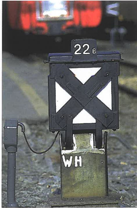
Weichensignal einer Doppelkreuzungsweiche.
